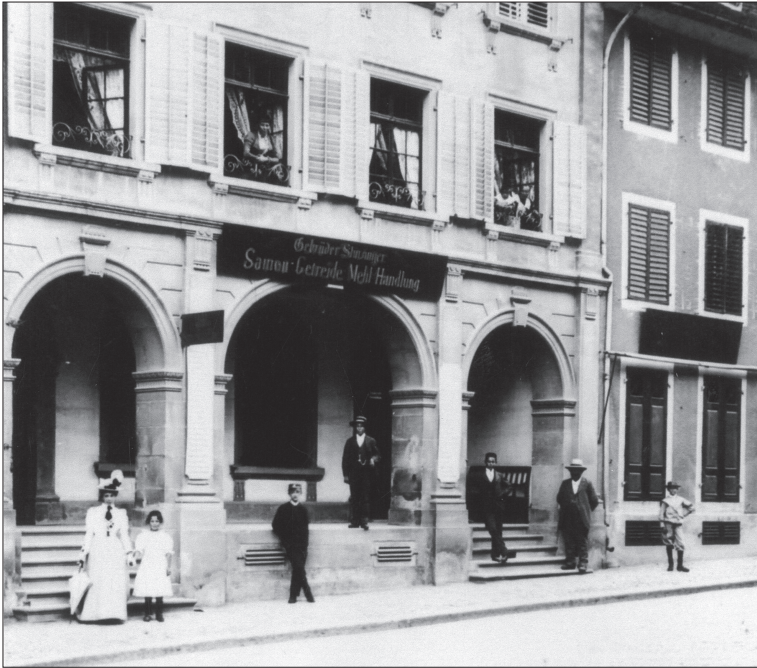
Das Walzmühlekontor um 1912 unter den Gebr. Stürzinger.
